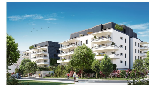
BATIMENT D - MONTEE 5 APPARTEMENT T3 N°5001 au Rez de jardin
